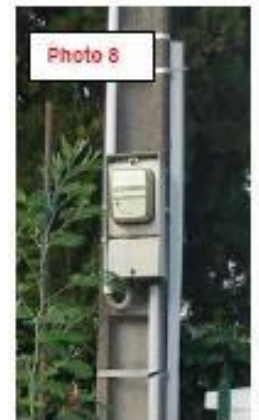
Compteur extérieur apparent
